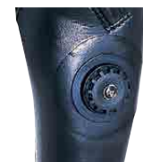
排気バルブ回り (1カ所) (補強)
