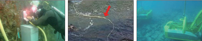
水中溶接作業
